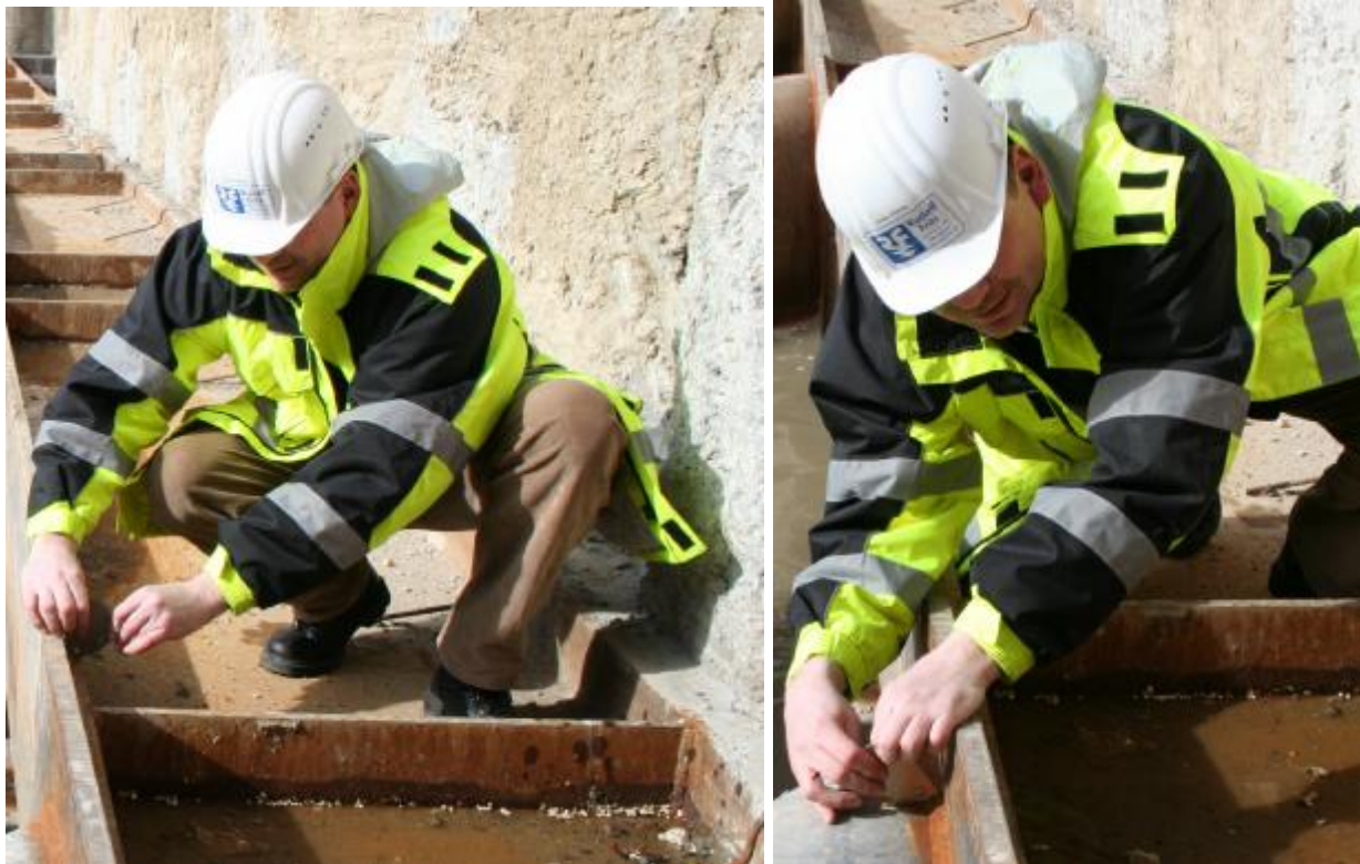
Schweißaufsicht bei der a-Maß Kontrolle.
